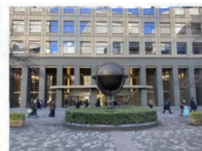
ビル中央入口
